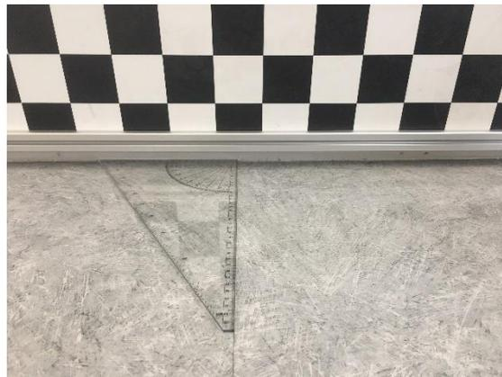
*Trouver une ligne perpendiculaire au mur*
